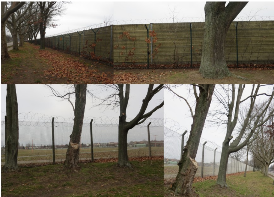
Abb. Absperrungen mit Zäunen auf langen Flächen, Beispiel Flughafen Tegel mit und ohne Sichtschutz
